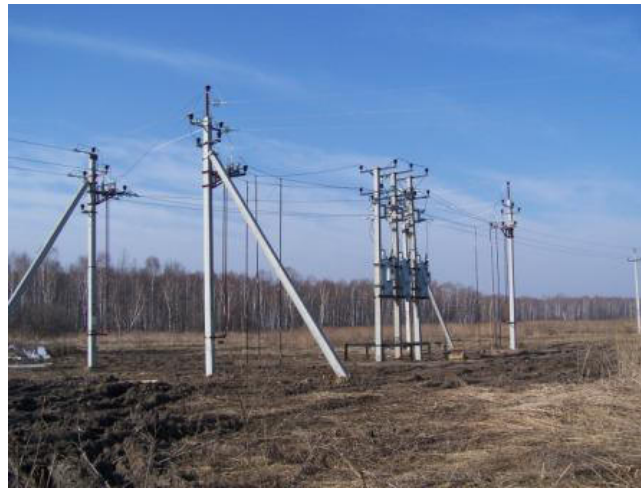
Рис. 2. Пример установки ВДТ в линии 10(6) кВ
